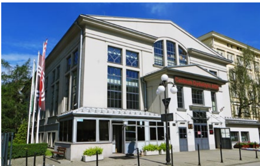
Budynek Laboratorium Maszynowego, obecnie Centrum Dydaktyczne AGH
