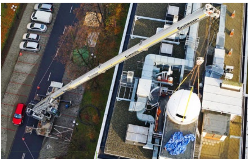
Montowanie kopuły na dachu WGGiIŚ
