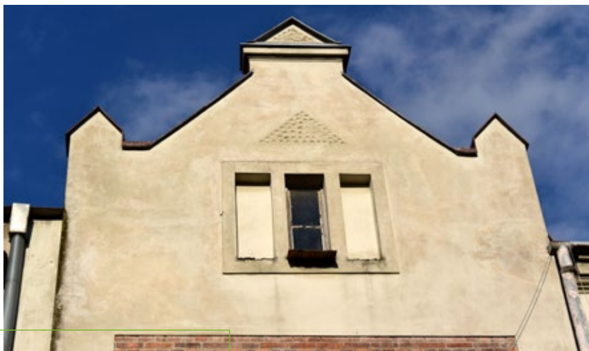
Zwieńczenie kamienicy przy ul. Urzędniczej
