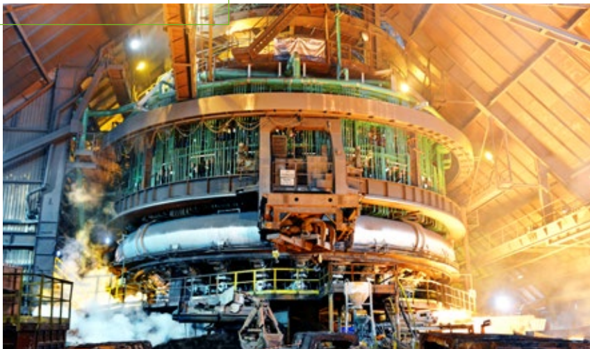
Wielki piec nr 5 w krakowskim oddziale ArcelorMittal Poland
