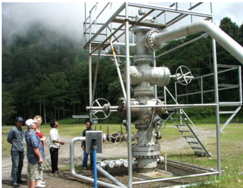
Głowica wysokotemperaturowego odwiertu geotermalnego budowanej elektrowni w Indonezji
