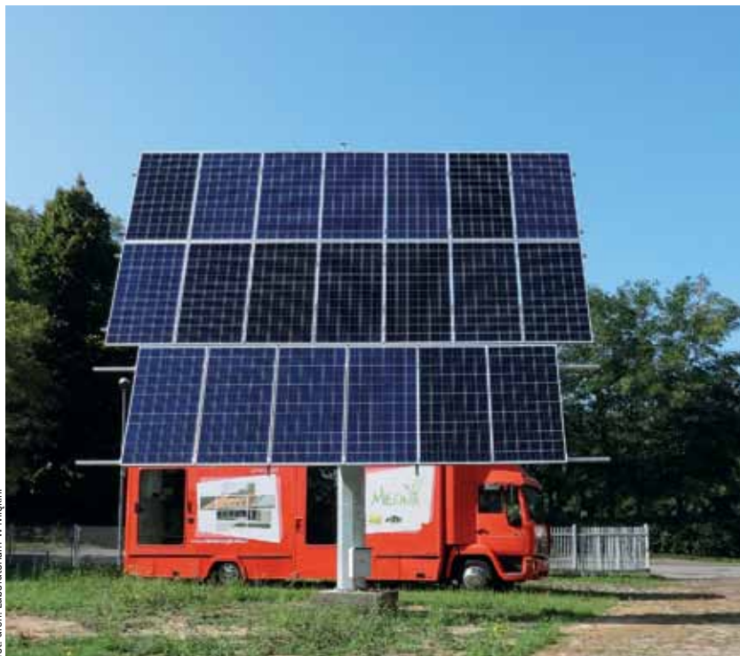
W pierwszym planie instalacja fotowoltaiczna na systemie nadajnym. W tle samochód z mobilną ekspozycją urządzeń OZE.
