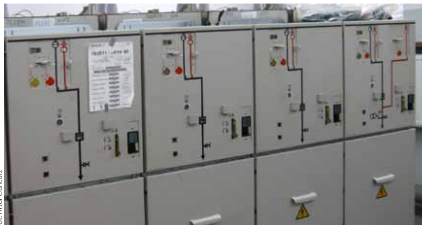
Rozdzielnica średniego napięcia 6 kV typu NXPLUS C przekazana przez firmę SIEMENS
