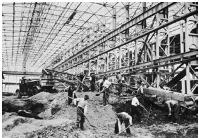
Budowa hali walcowni Huty im. Lenina, 1950, fot. H. Hermanowicz, wł. MHK
