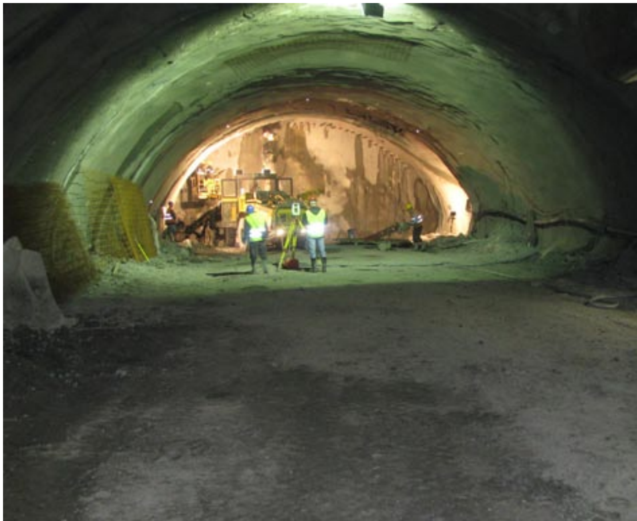
Drążenie tunelu „Emilia” w Lalikach (droga ekspresowa S69 Szare–Laliki)
