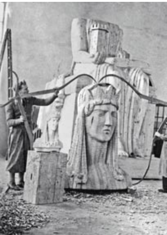
Figura św. Barbary – model z drewna, na który nałożono konstrukcję żelazną, a następnie z blachę miedzianą
