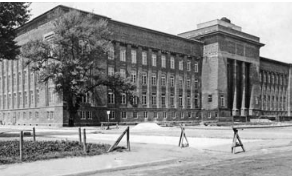
Budowa gmachu Akademii Górniczej pod koniec lat 20.
